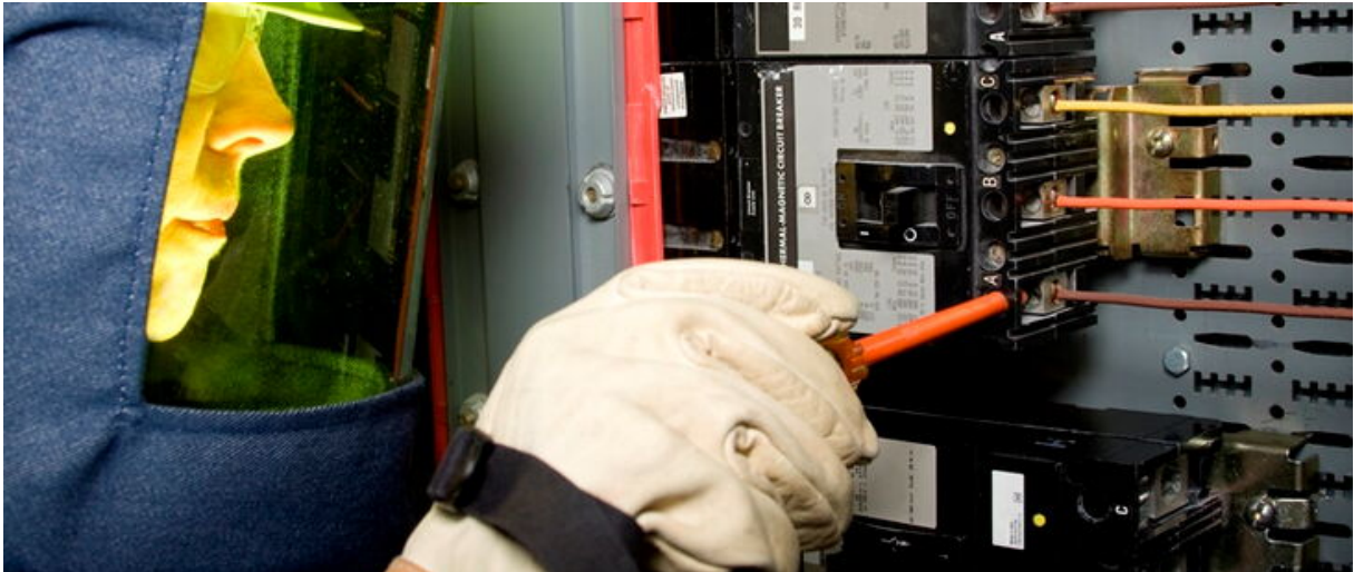
Arbeitsanweisungen für ein sicheres elektrotechnisches Arbeiten (Bildquelle: Shinyfamily/iStock/Thinkstock)
