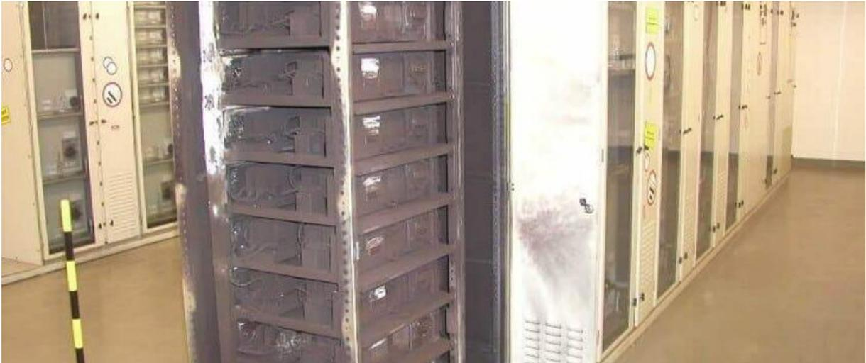
Geöffneter Einschubschrank nach Explosion der NH-Sicherung und nachfolgende Störlichtbogen. (Bildquelle: Dr.-Ing. Jens Jühling)
