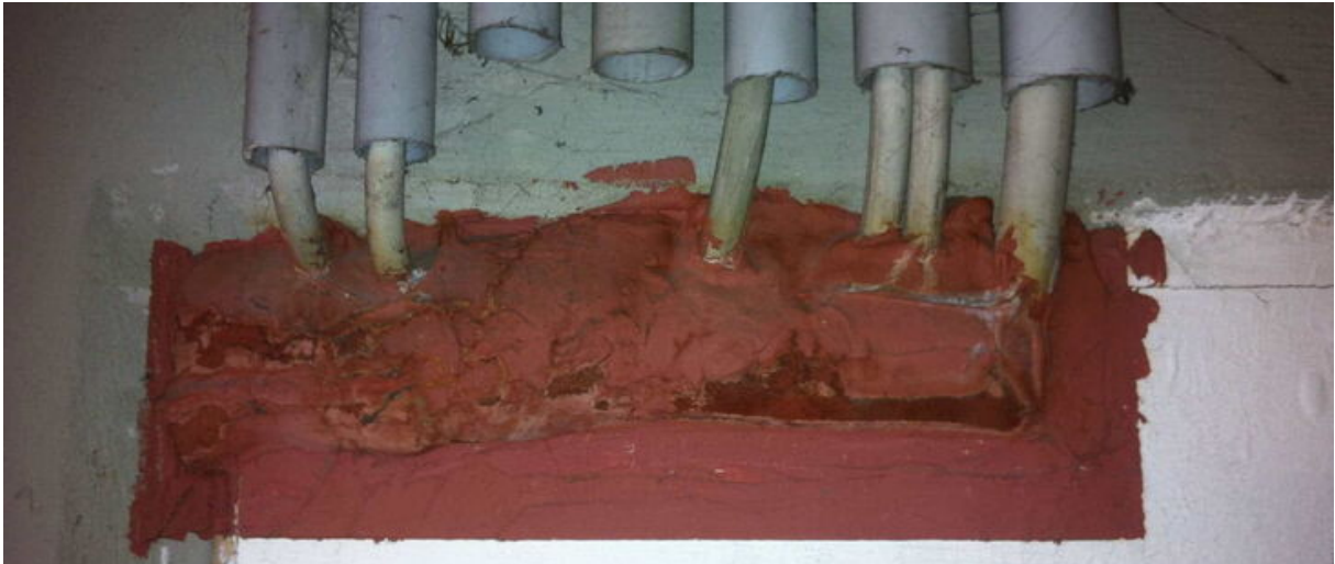
Deckendurchbruch mit Leitungsbündel (Bildquelle: Dr.-Ing. Jens Jühling)
