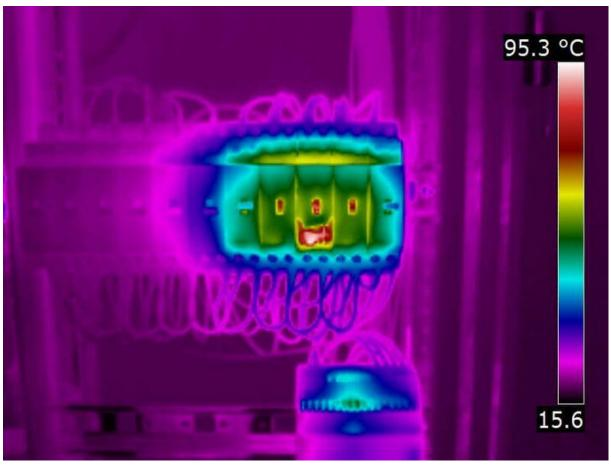
Überhitzung eines LS-Schalters aufgrund eines Isolationsfehlers
