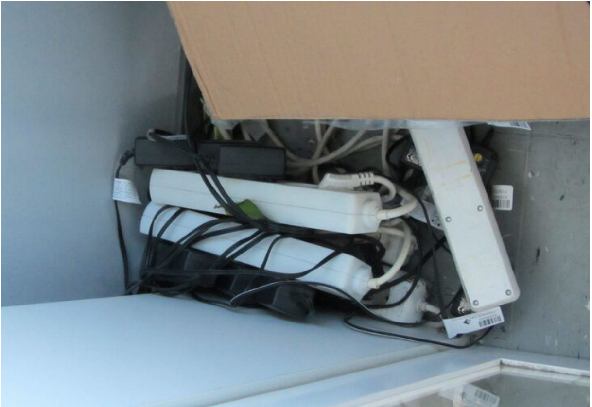
Unzulässiges Hintereinanderschalten von Steckdosenverteilern
