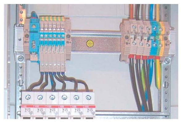
Abb. 2: PTSK mit richtig aufgebauter Schutzleiterschiene (die Schutzleiterschiene ist vom Geräteträger isoliert)
