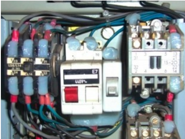
Unkonventionell, aber der Berührungsschutz für die Mitarbeiter ist gewährleistet
