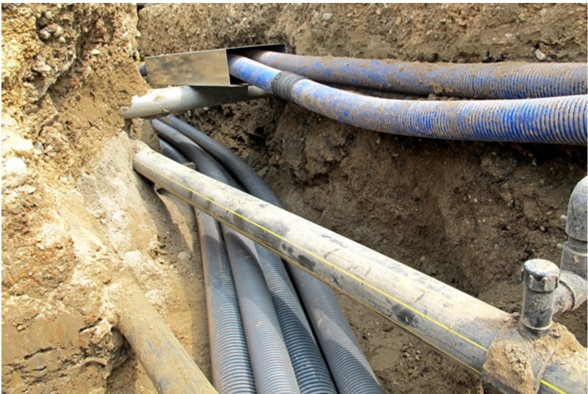
VDE-AR 4221: Rechtssicherheit bei der Kabelverlegung statt Reparaturen und Nacharbeiten (Bildquelle: ChiccoDodiFC/iStock/Getty Images)
