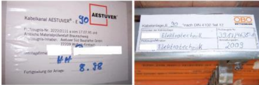
Abb. 2: Beispiele für Trassenkennzeichnungen
