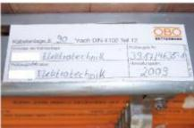
Abb. 2: Beispiele für Trassenkennzeichnungen
