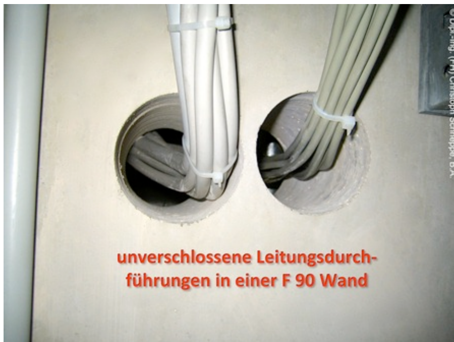
Unverschlossene Leitungsdurchführungen in einer F 90 Wand
