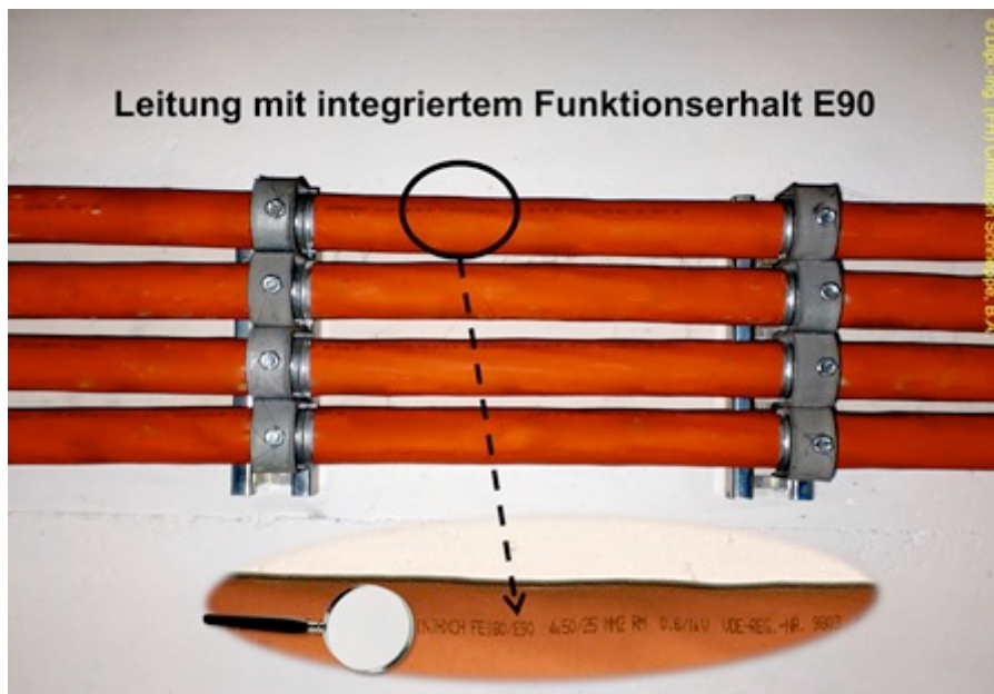
Leitung mit integriertem Funktionserhalt E90
