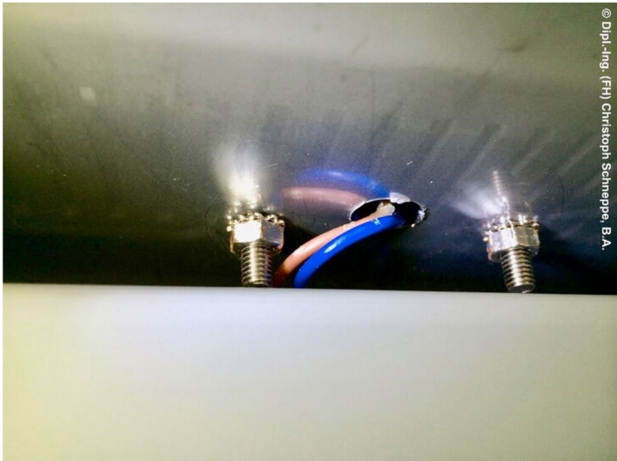
Basisisolierte Leitungsadern ohne ausreichenden Kantenschutz
