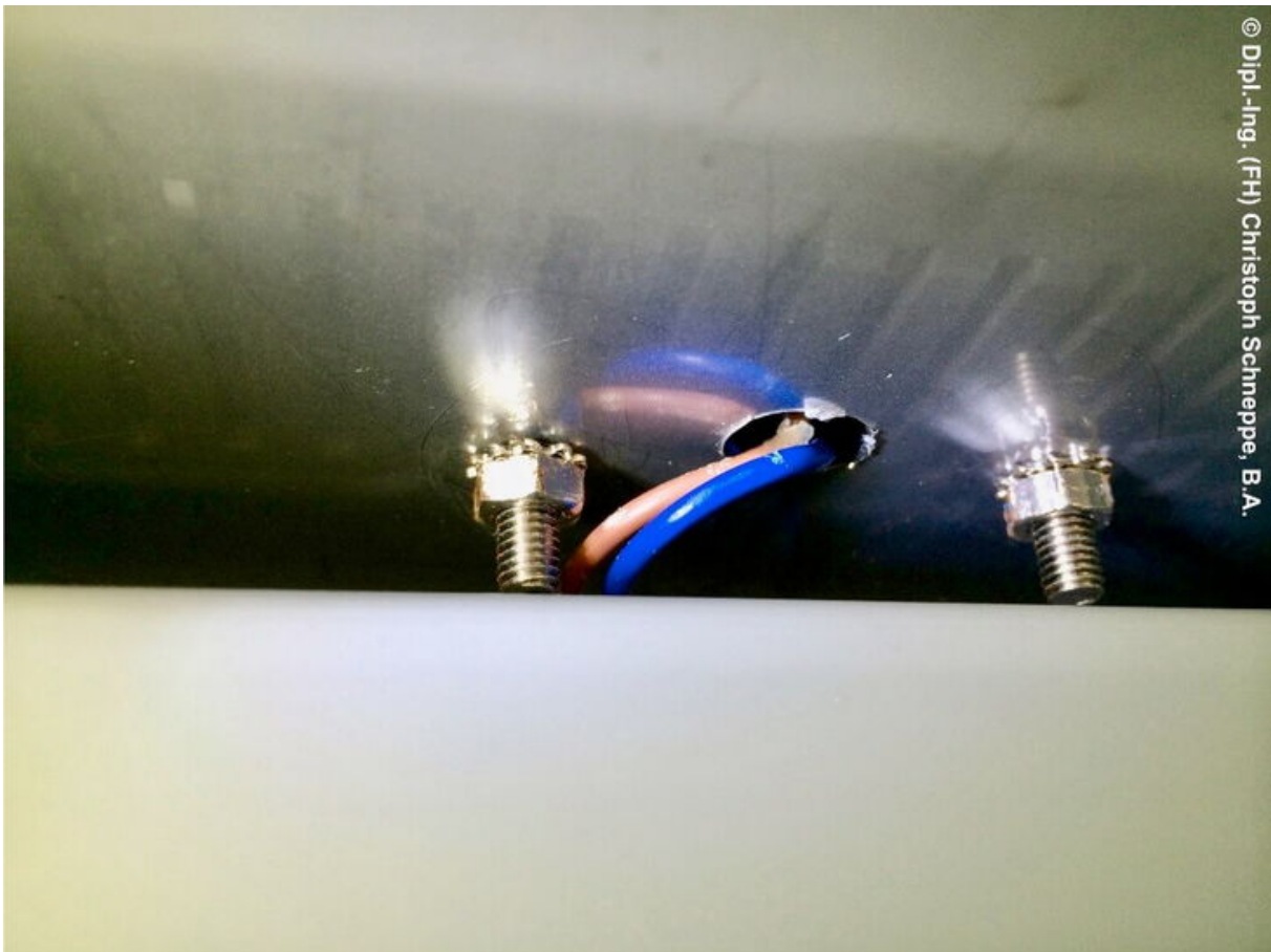
Basisisolierte Leitungsadern ohne ausreichenden Kantenschutz
