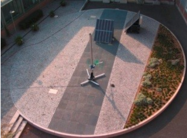
Abb. 3: EMV-Messung der elektromagnetischen Abstrahlung eines PV-Generators (Quelle: ISET)
