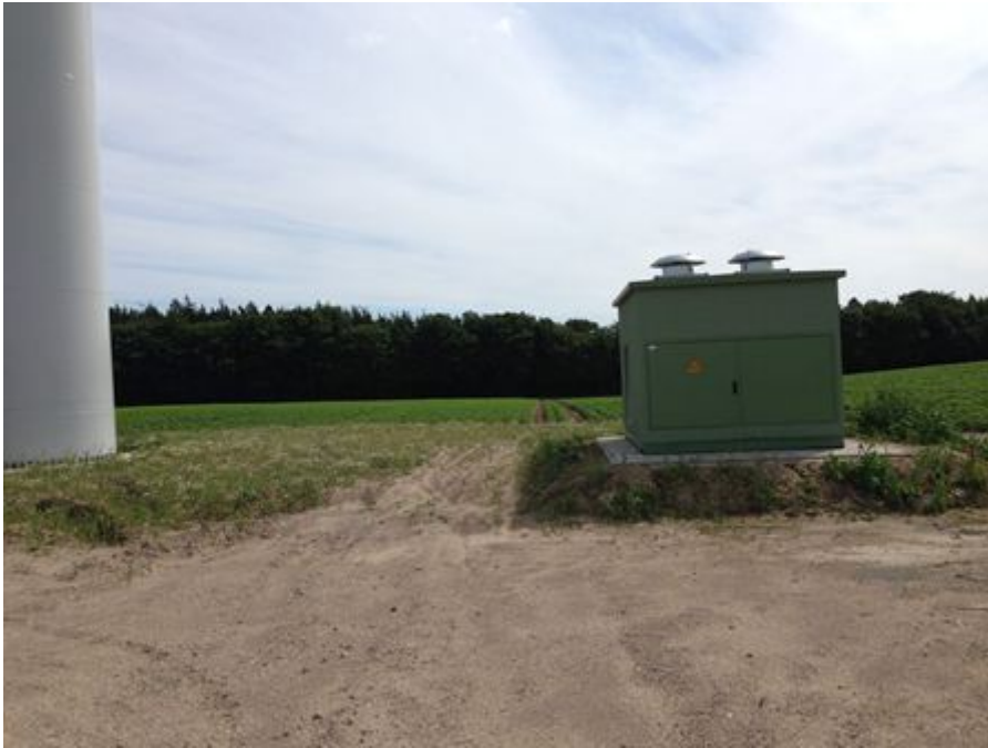
Abb. 4: Typische Installationsanordnung der Mittelspannungs-Einrichtungen bei einer Multimegawatt-Windenergieanlage
