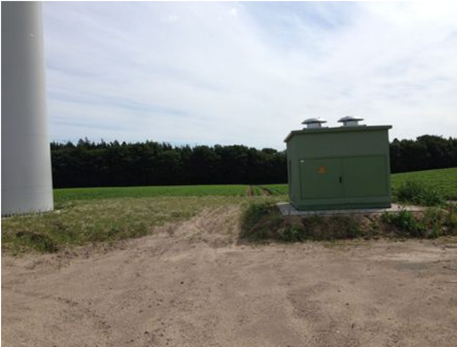
Abb. 4: Typische Installationsanordnung der Mittelspannungs-Einrichtungen bei einer Multimegawatt-Windenergieanlage
