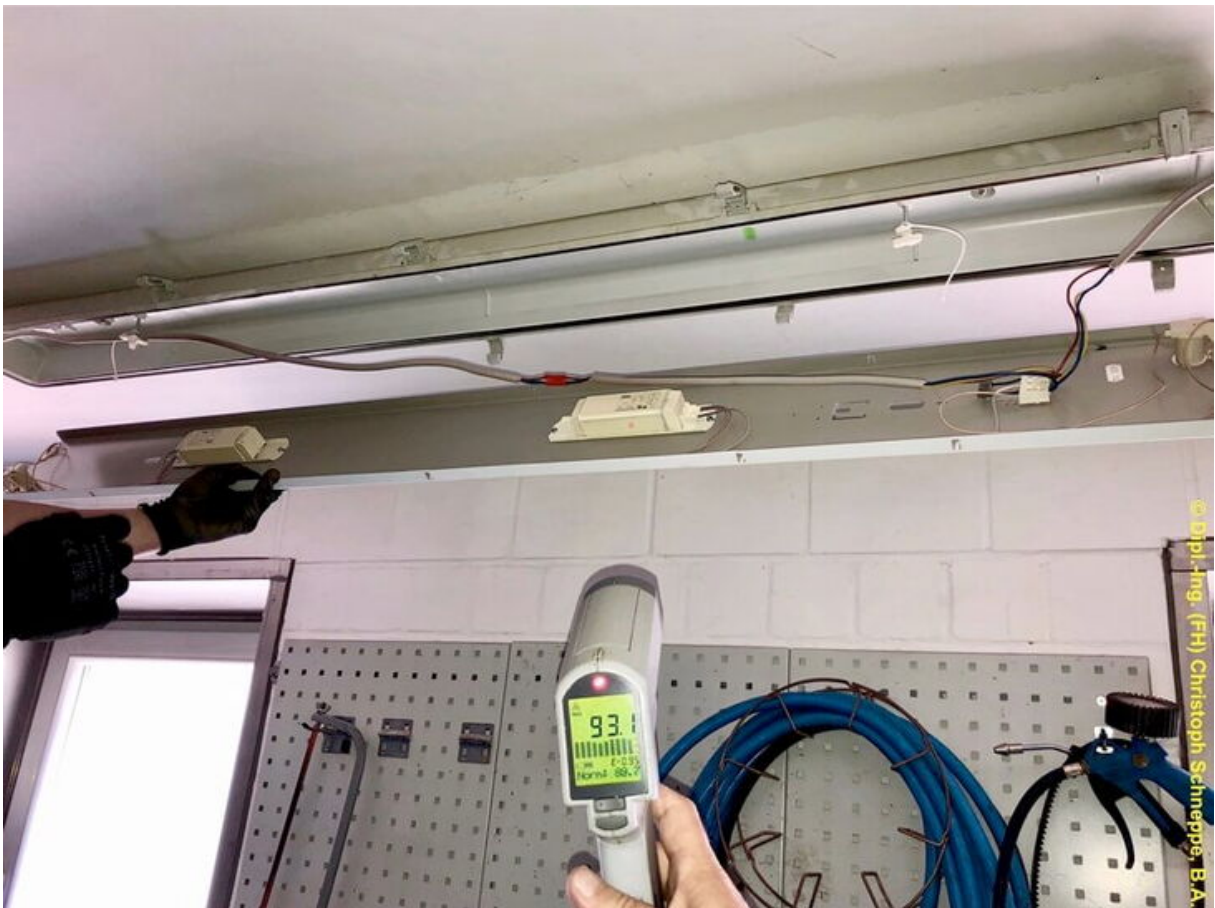
Bei Oberflächentemperaturen von über 90 °C sind Schädigungen der Leitungsisolierungen der Durchverdrahtung nicht auszuschließen. (Bildquelle: Dipl.-Ing. (FH) Christoph Schneppe, B.A.)
