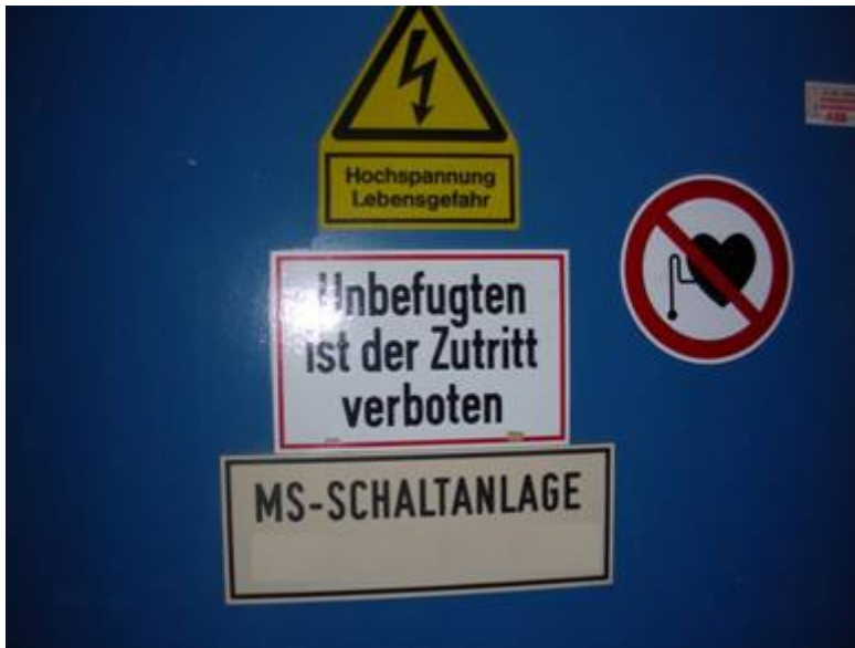
Beispiel „Abgeschlossene elektrische Betriebsstätte“
