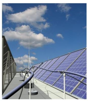
Abb. 1a und b: Auslegung der Fangeinrichtungen unter Beachtung von Schattenbildung und erforderlichen Trennungsabstand s (Quelle: Dehn + Söhne, www.dehn.de)
