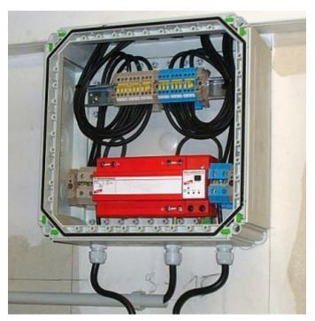
Abb. 7: Kombi-Ableiter Typ 1 zum Schutz von PV-Wechselrichtern auch bei direkten Blitz-Einschlägen (Pos. 1 im Bild 6) (Quelle: Dehn + Söhne, www.dehn.de)
