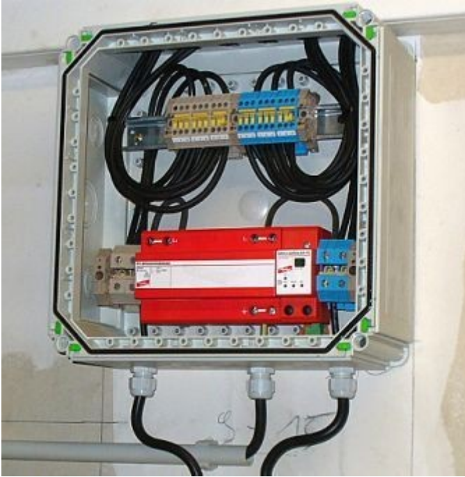
Abb. 7: Kombi-Ableiter Typ 1 zum Schutz von PV-Wechselrichtern auch bei direkten Blitz-Einschlägen (Pos. 1 im Bild 6) (Quelle: Dehn + Söhne, www.dehn.de)
