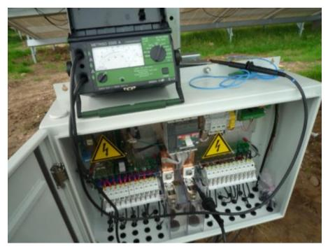
Abb. 1: Isolationsmessung am Generatoranschlusskasten (Quelle: Fa. K&S, www.krugundschram.de)
