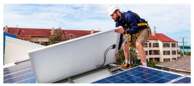
Bei Arbeiten unter Spannung an Photovoltaikanlagen entsteht eine erhöhte Gefahr der Körperdurchströmung. (Bildquelle: zstockphotos/iStock/Getty Images)
