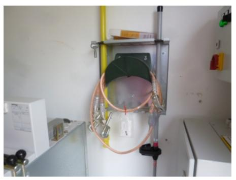
Abb. 3: Brandschaden, verursacht durch verpolte Stringverkabelung im Generatoranschlusskasten (Quelle: Fa. K&S)
