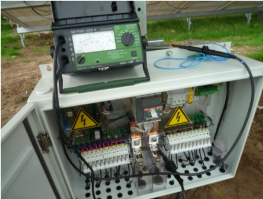
Abb. 1: Isolationsmessung am Generatoranschlusskasten (Quelle: Fa. K&S, www.krugundschräm.de )
