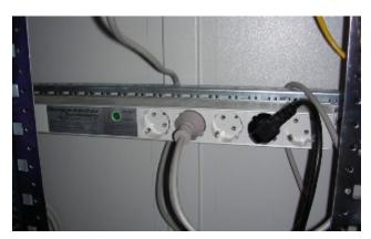
Abb. 2: Steckdosenleiste mit integriertem Überspannungsschutz
