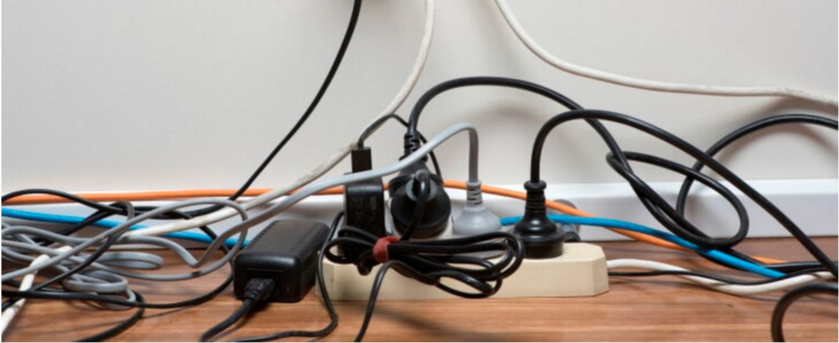
Abb. 1: Kaskadierte Steckdosenleisten (Bildquelle: davidmariuz/iStock/Thinkstock)
