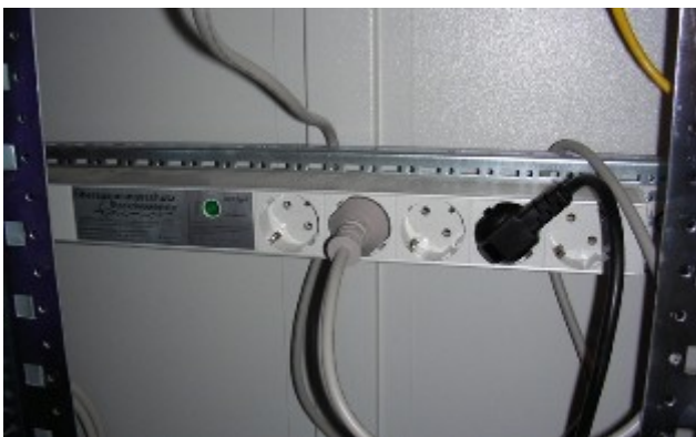
Abb. 2: Steckdosenleiste mit integriertem Überspannungsschutz
