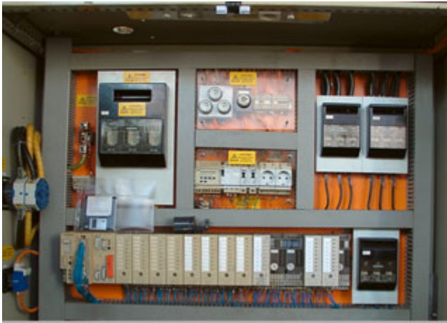
Abb. 1a: Beispiel für die ordnungsgemäße Ausführung des Handrücken- bzw. Fingerschutzes in einem Schaltschrank. Die Betriebsmittel auf der Leiste der Schubeinsatztechnik weisen einen teilweisen Berührungsschutz auf
