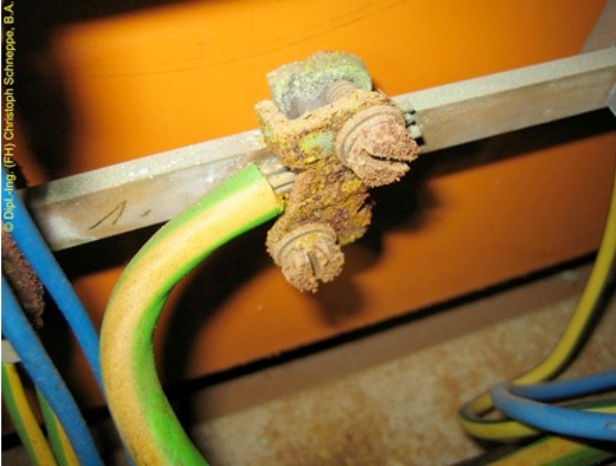
Korrodierte Klemmverbindung
