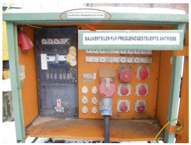
Abb. 1: Baustromverteiler für frequenzgesteuerte Antriebe
