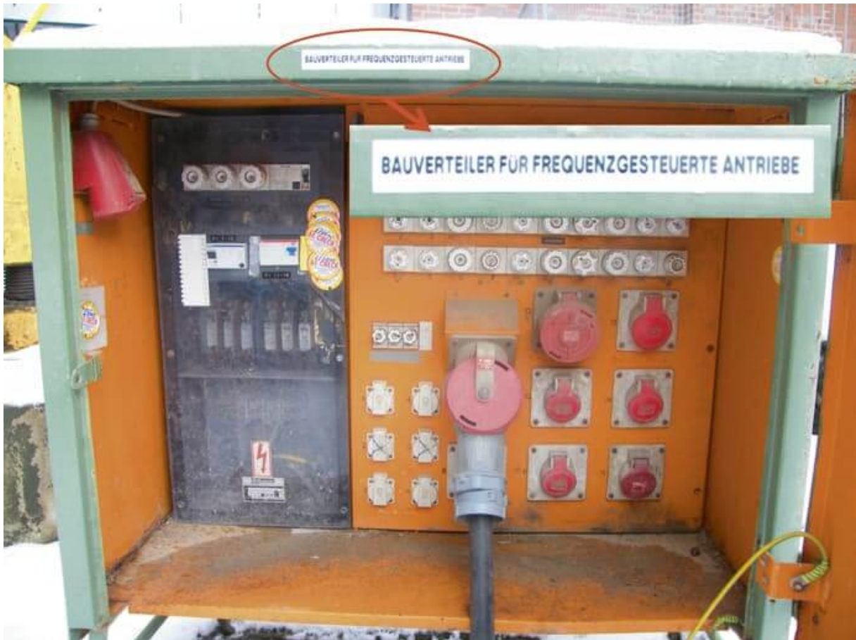
Abb. 1: Baustromverteiler für frequenzgesteuerte Antriebe
