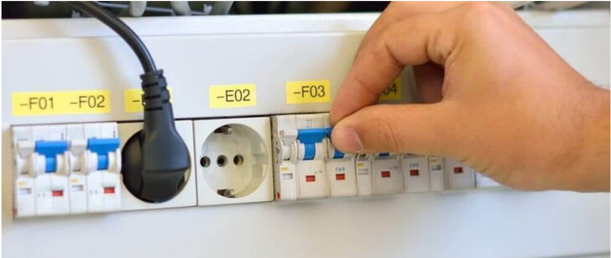
RCDs schützen vor Berührungsspannung. (Bildquelle: Shinyfamily/iStock/Thinkstock)
