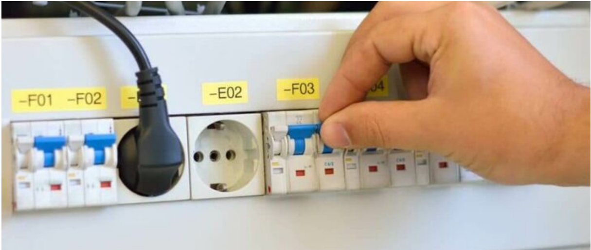
RCDs schützen vor Berührungsspannung. (Bildquelle: Shinyfamily/iStock/Thinkstock)
