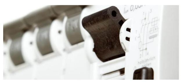
Bei Erst- und Wiederholungsprüfungen sind Messungen an den Fehlerstrom-Schutzeinrichtungen durchzuführen. (Bildquelle: sb-
