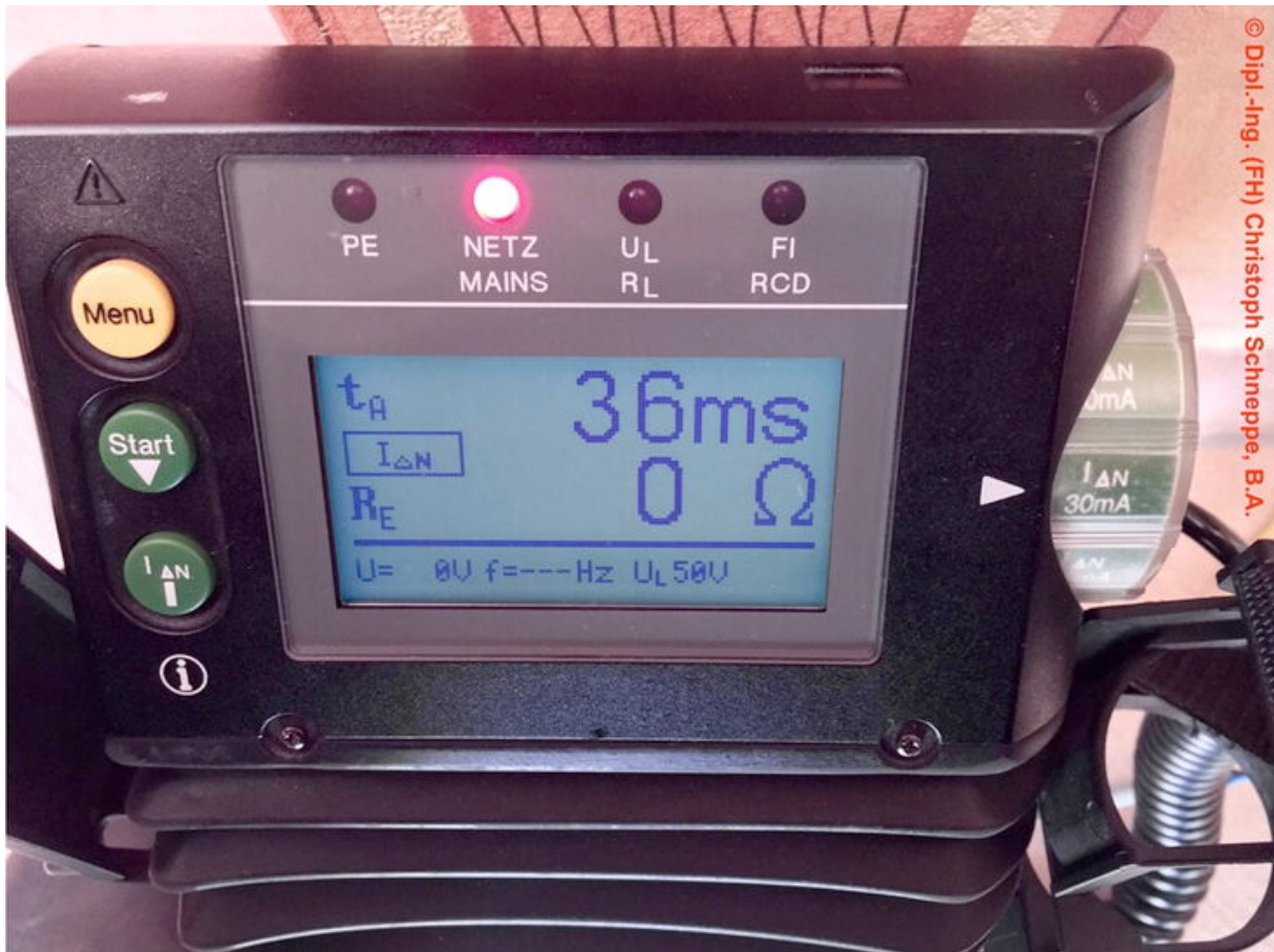
Messung der Auslösezeit an einem Steckdosenstromkreis mit Fehlerstrom-Schutzeinrichtung (RCD)
