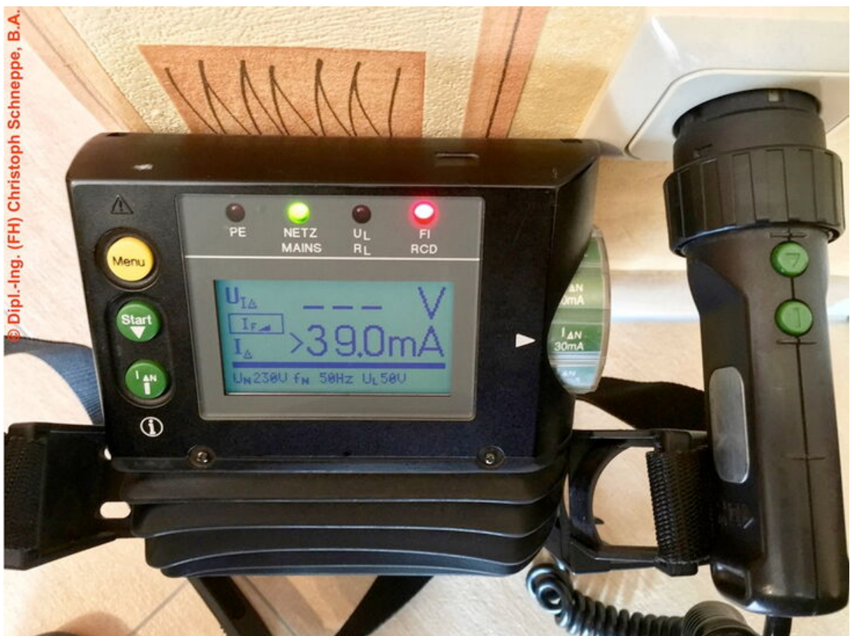
Messung des Auslösestroms an einem Steckdosenstromkreis mit fehlerbehafteter Fehlerstrom-Schutzeinrichtung (RCD)
