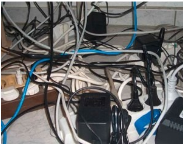
Unzulässiger Einsatz von ortsveränderlichen Mehrfachsteckdosen
