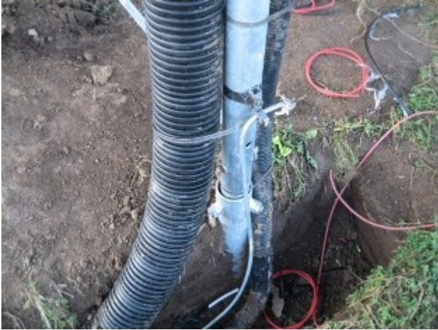
Anbindung des Modulgestells einer Photovoltaik-Freifeldanlage (eigene Aufnahme)
