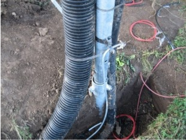
Anbindung des Modulgestells einer Photovoltaik-Freifeldanlage (eigene Aufnahme)
