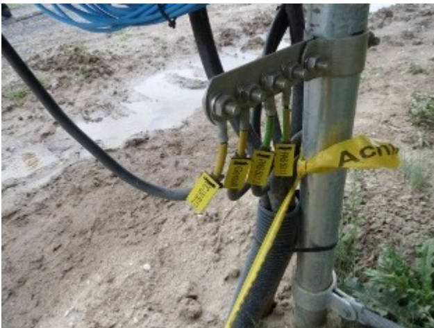
Anbindung mehrerer Modulgestelle bei einer Photovoltaik-Freifeldanlage (eigene Aufnahme)
