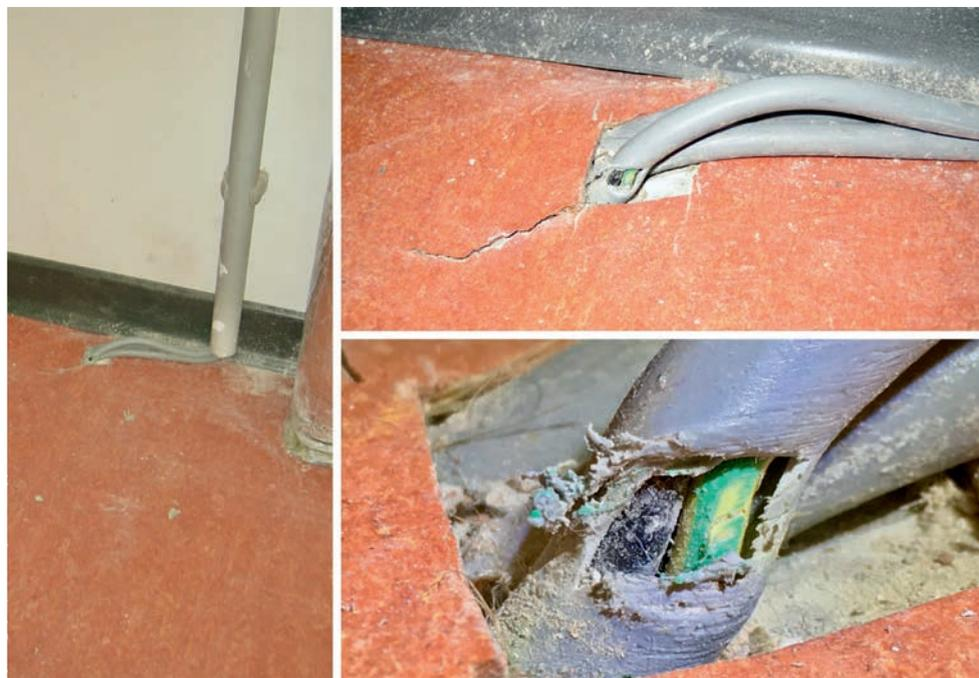
Geschädigte Leitungen aufgrund von fehlendem Schutz im Bodenbereich
