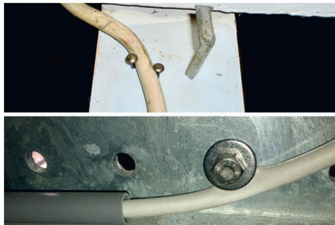
Nicht fachgerechtes bzw. falsches Befestigungsmaterial, das zu Beschädigungen bzw. Isolationsverlust der Leitungen führen kann
