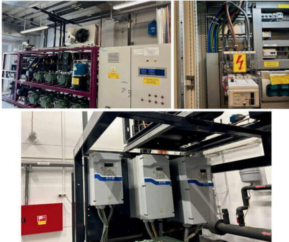
Elektrotechnischer Aufbau einer Gewerbekälteanlage (Bildquelle: Jörg Belzer, B.Eng., MBA)
